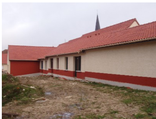
Vue de la cour intérieure
